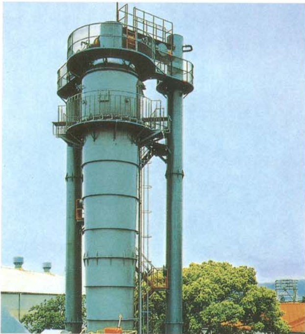
形 式：WTV 用 途：可塑剤ミスト ガス量：9,000Nm 3 /H ガス温度：60℃
