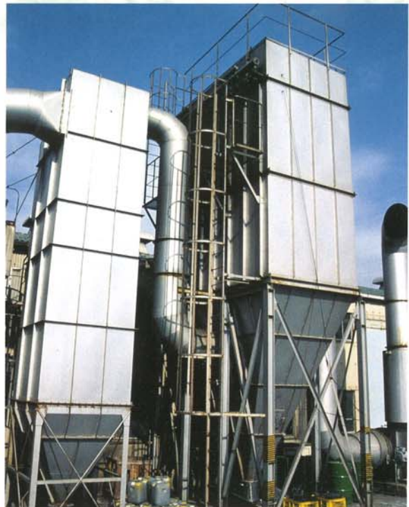
形 式：PD-130L 用 途：産業廃棄物焼却炉 ガス量：10,000Nm 3 /Hr ガス温度：60℃
