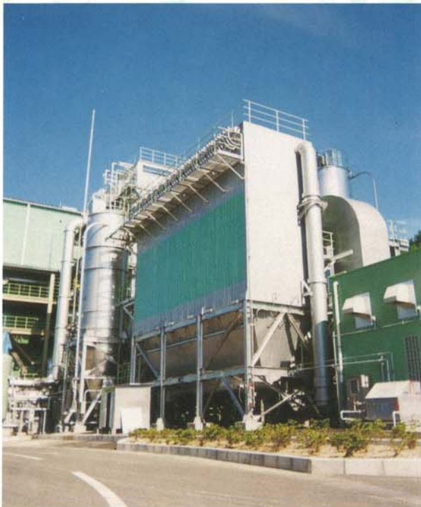
形 式：PD-630L 用 途：産業廃棄物焼却炉 ガス量：59,000Nm 3 /Hr ガス温度：200℃
