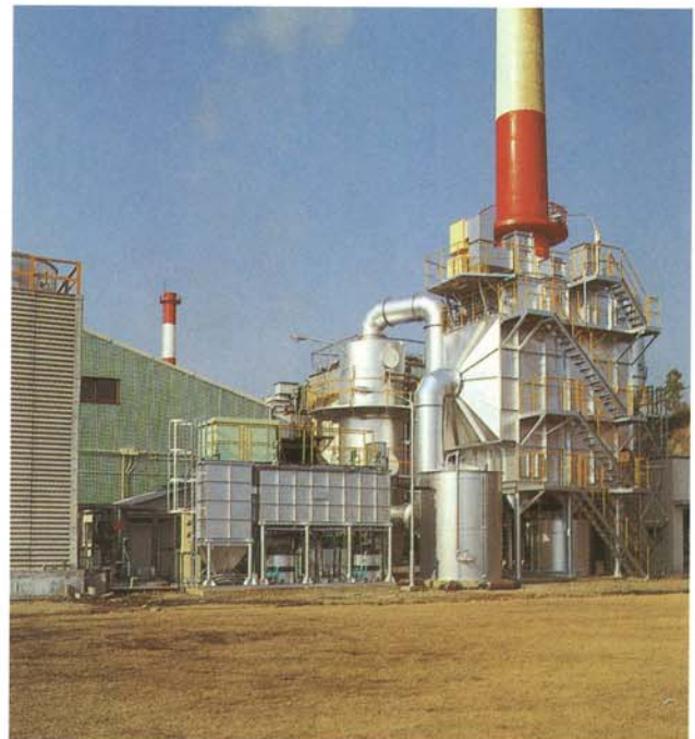
形 式：WSH 用 途：都市ごみ焼却炉 ガス量：23,000Nm 3 /H ガス温度：250℃
